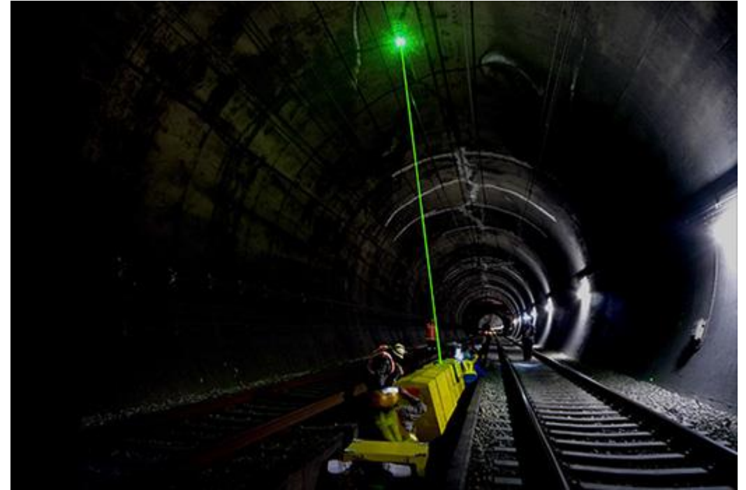
JR西日本 レーザーによるコンクリート欠陥検出装置 ( https://www.westjr.co.jp/company/action/technology/technology/10/ )
